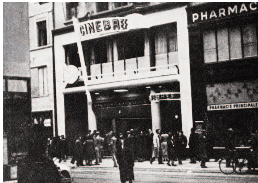
Atelier d'Architectes, Cinébrief, rue du Marché 9-11, Genève. Photographie parue dans La Cinématographie française à l'occasion de l'ouverture du cinéma, le 30 septembre 1936.
