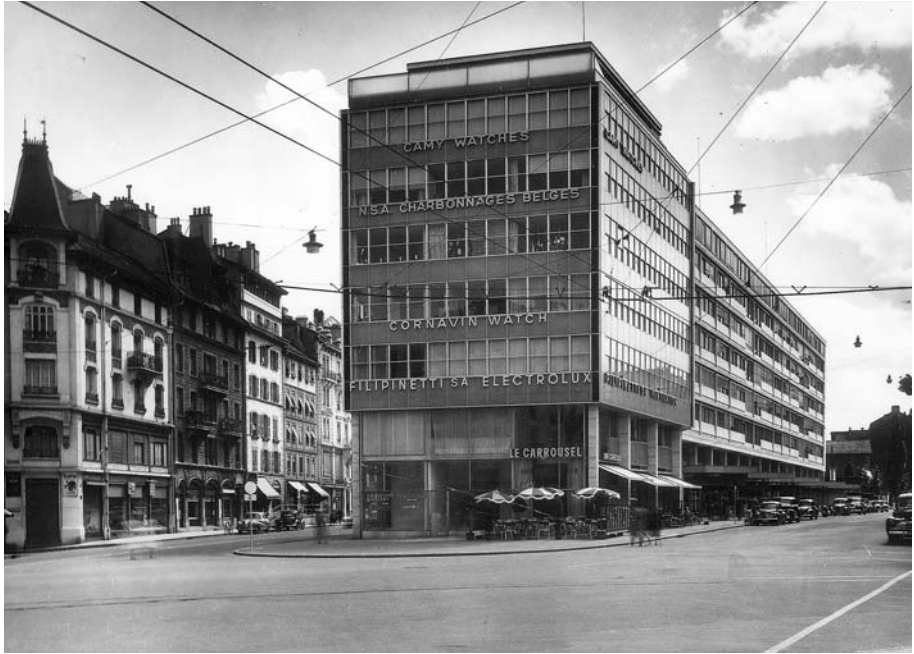
Terreaux-Cornavin, la façade de l'immeuble de tête qui abrite des bureaux fonctionne comme grille qui sert de support à l'accrochage de publicités, ici Filipinetti, le maître d'ouvrage du bâtiment. Photographie J. Zimmer-Meylan, Bibliothèque de Genève
