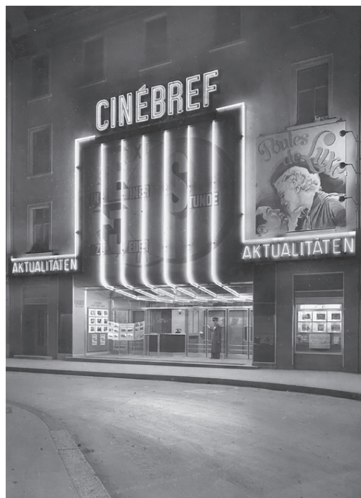
J. Pfister-Picault, Cinébrief, Beatengasse 15, Zurich, 1937. Les néons verticaux disposés sur la façade se recourbent vers les caisses et l'intérieur de la salle. Le slogan «In einer Stunde zu jeder Stunde» se lit derrière les tubes.
