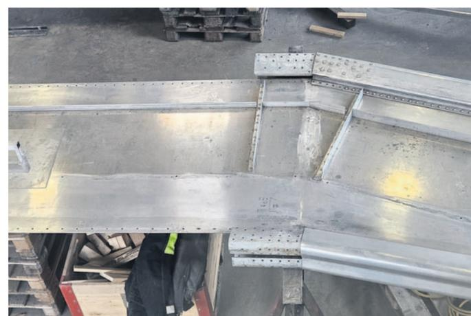
La réparation des poutres dans les ateliers Morand. Le robot soudeur et les différentes techniques d'assemblage mises en œuvre : soudure pour le raccord de l'âme de la poutre, rivure pour l'assemblage des coques à l'âme et vissage avec des vis aluminium pour le raccord entre les différentes parties de la coque. Photographies Morand constructions métalliques
