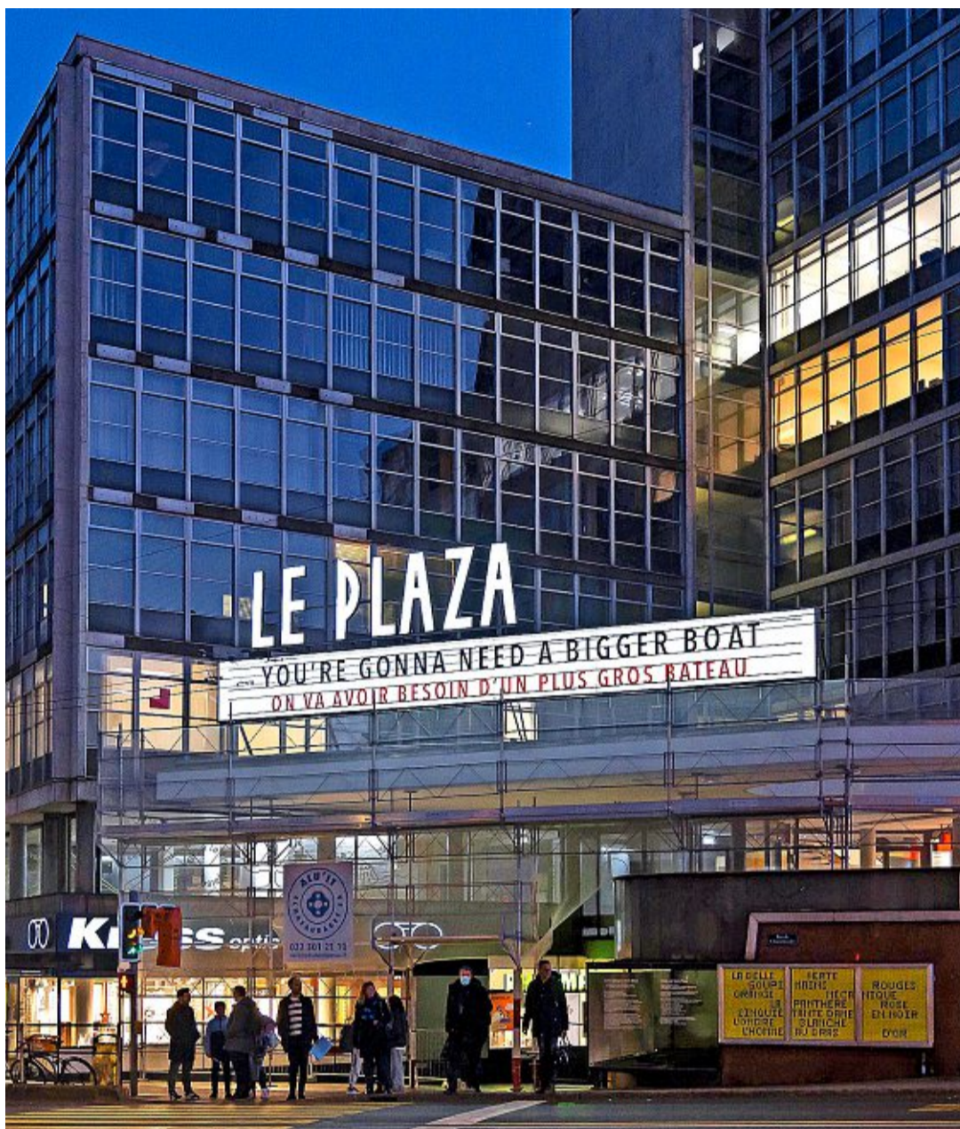
En grand ci-dessus, la façade du Plaza. En haut à droite, l'intérieur de la salle, tel qu'il se présente aujourd'hui, désossé et prêt pour les travaux. CHRISTIAN ROBERT TISSOT/MICHEL GIESBRECHT
